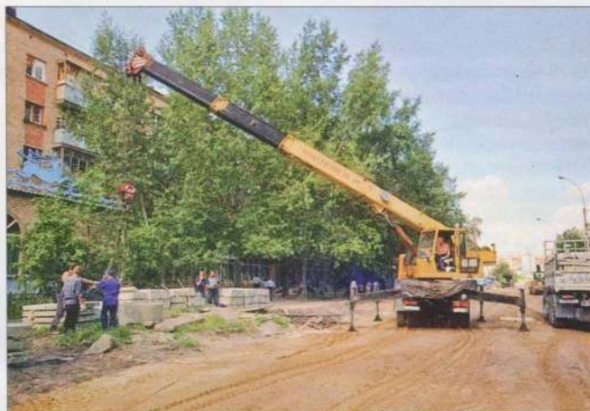
Улица Юбилейная во время ремонта. Фото Ирины Санниковой
