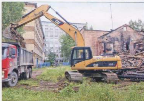
22 августа 2008 г. строительная организация «Стройинвест Коми» приступила к разборке стен «Пассажа».
