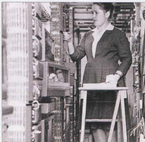
Высота оборудования декадно-шаговой АТС была около 2,5 метра, поэтому Галине Павловой приходилось настраивать приборы, стоя на стремянке (1954 год).
