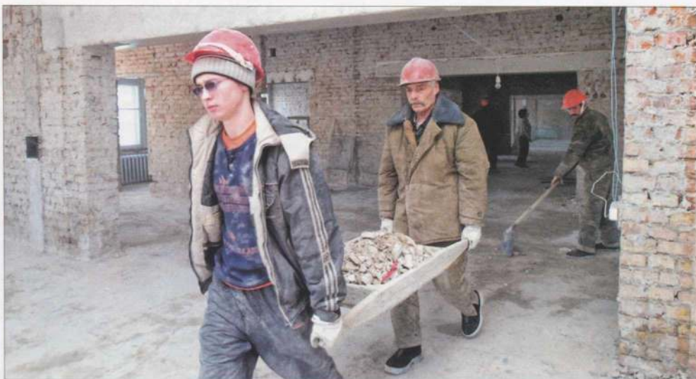
Ремонтные работы проводит фирма «Бетиз». Фото Александра Скорнякова
